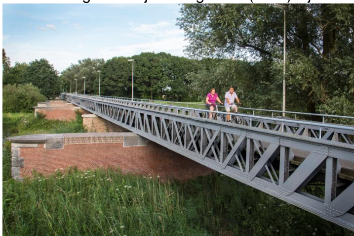
Figuur 1: Noordzijde van de spoorbrug tussen Waalwijk en Drunen
